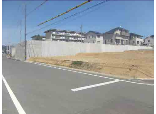
擁壁（区画整理事業）新設工事
