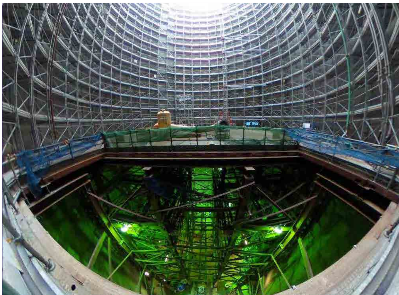
鋼殻ケーソン（鋼殻は台船で曳航）
