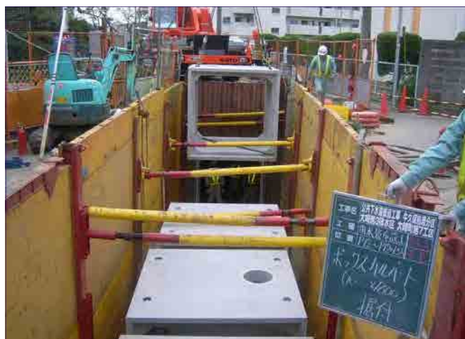
開削（□1800 ボックスカルバート）
