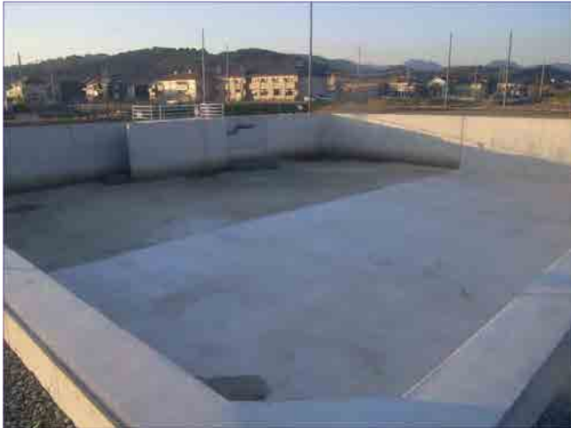
雨水調整池工事
