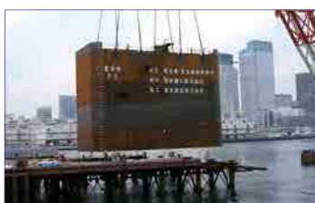
鋼殻ケーソン（鋼殻は台船で曳航）
