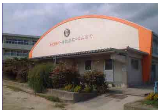
小学校屋内運動場
