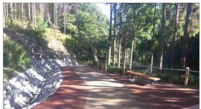
散策路工事（木チップ舗装、自然石護岸）
