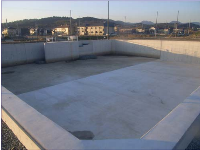
雨水調整池工事
