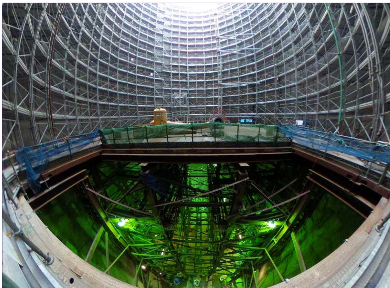
鋼殻ケーソン（鋼殻は台船で曳航）
