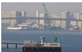
鋼殻ケーソン（鋼殻は台船で曳航）
