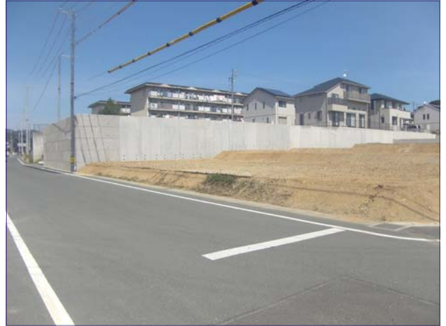
擁壁（区画整理事業）新設工事
