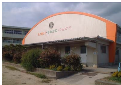
小学校屋内運動場
