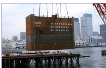
鋼殻ケーソン（鋼殻は台船で曳航）
