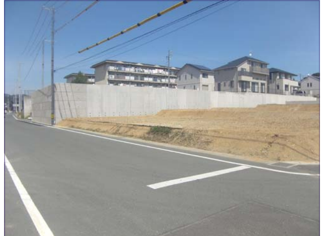
擁壁（区画整理事業）新設工事
