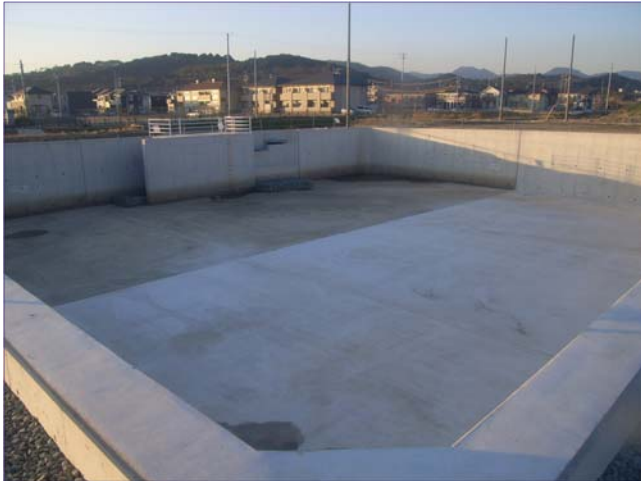
雨水調整池工事
