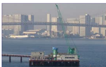
鋼殻ケーソン（鋼殻は台船で曳航）
