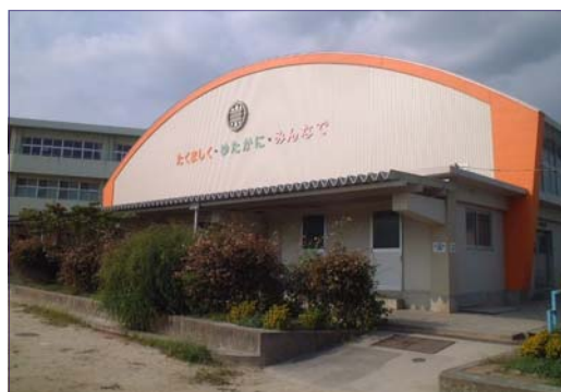
小学校屋内運動場
