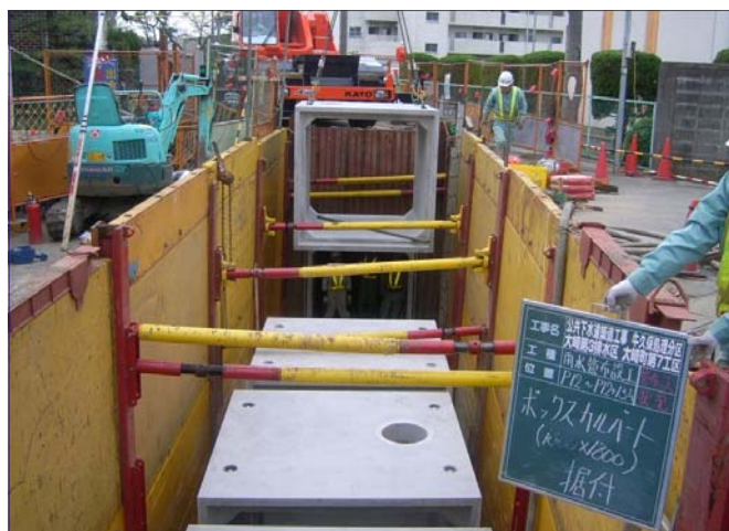
開削（□1800 ボックスカルバート）
