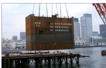
鋼殻ケーソン（鋼殻は台船で曳航）
