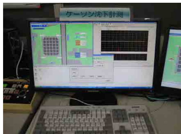
ケーソン沈下計測
