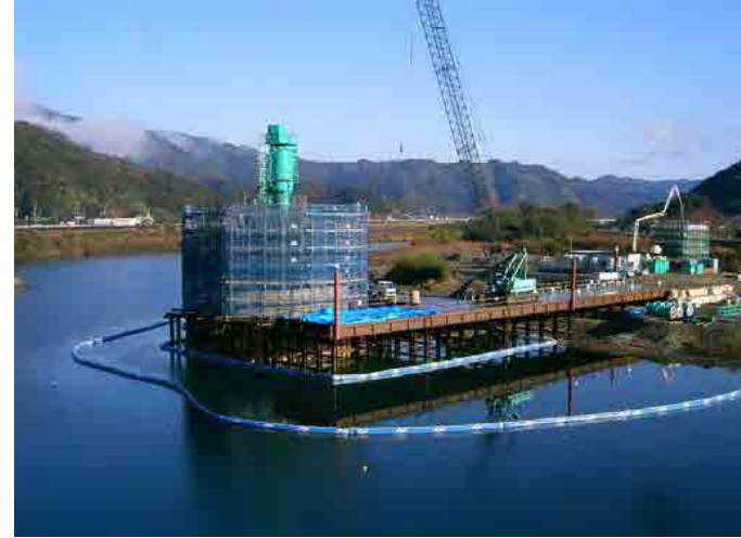
ピアケーソン (橋脚)
