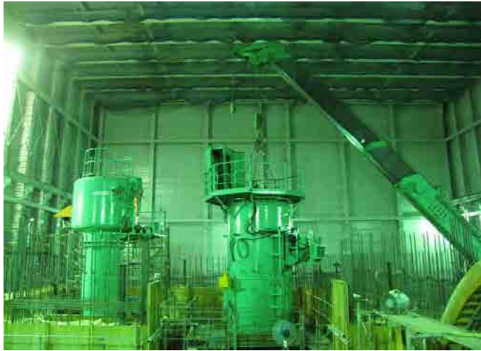
放水路（シールド発進立坑）
